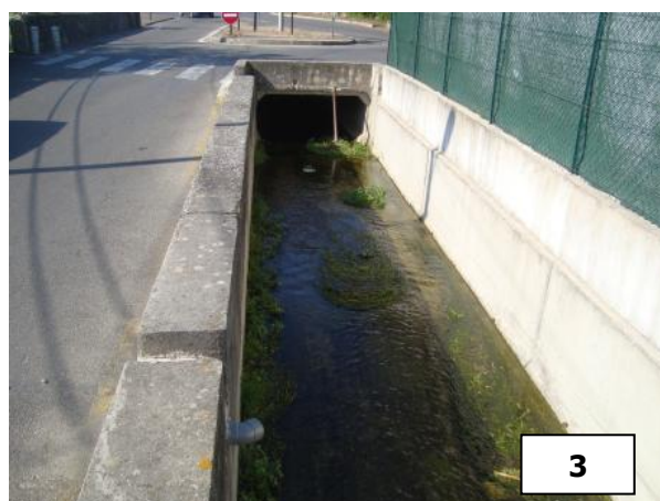
Figure 22 : Localisation et photographies de la zone 1
