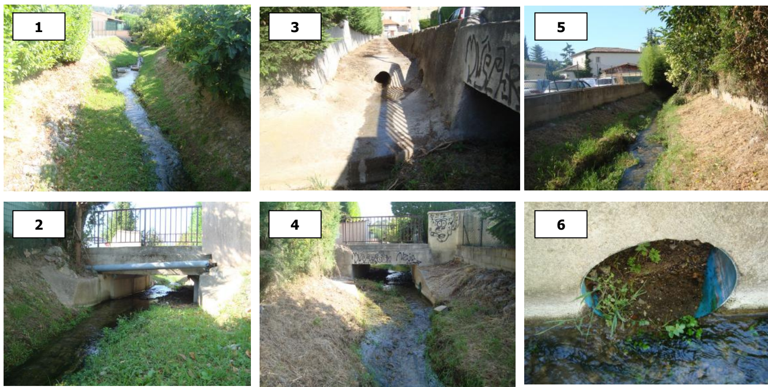
Figure 25 : Localisation et photographies de la zone 2
