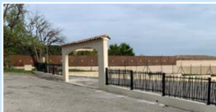
Cimetière de Clavary Un portique et un muret ont été créés à l'entrée du cimetière de Clavary pour éviter les installations et stationnements sauvages.
