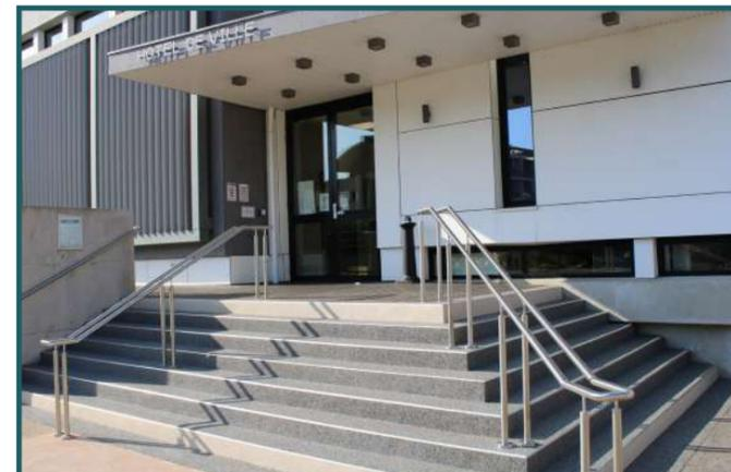
Sécurisation des escaliers extérieurs d'accès principal au centre administratif avec le remplacement du carrelage glissant et dangereux par un revêtement antidérapant et l'ajout d'une rampe.
