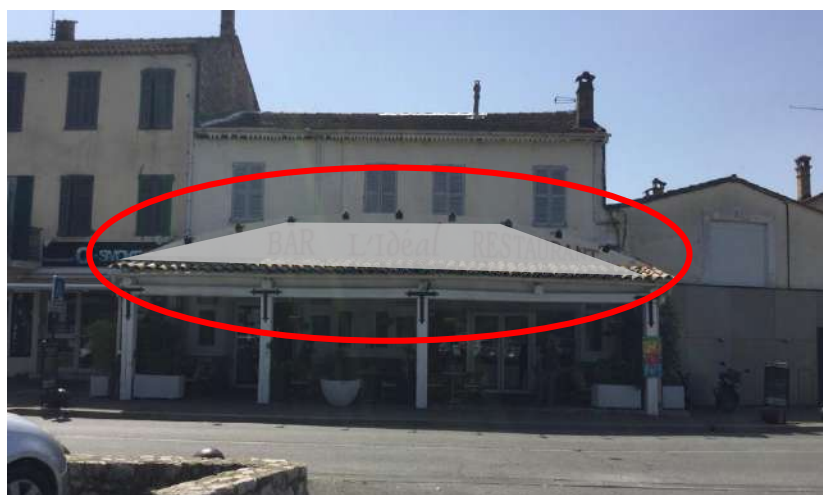
Enseigne sur auvent, réalisée avec un panneau de fond et masquant l'architecture des bâtiments, Pégomas.
