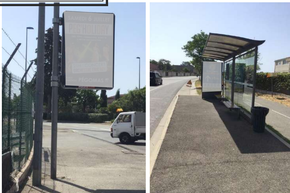
Mât porte-affiche et abris destiné au public supportant de la publicité, Pégomas.
