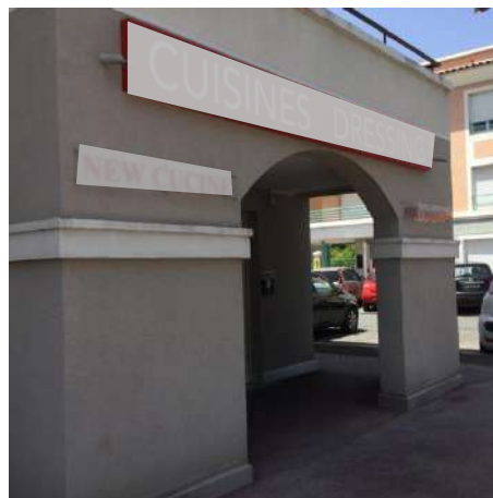
Enseignes parallèles réalisées avec un panneau de fond, Pégomas.
