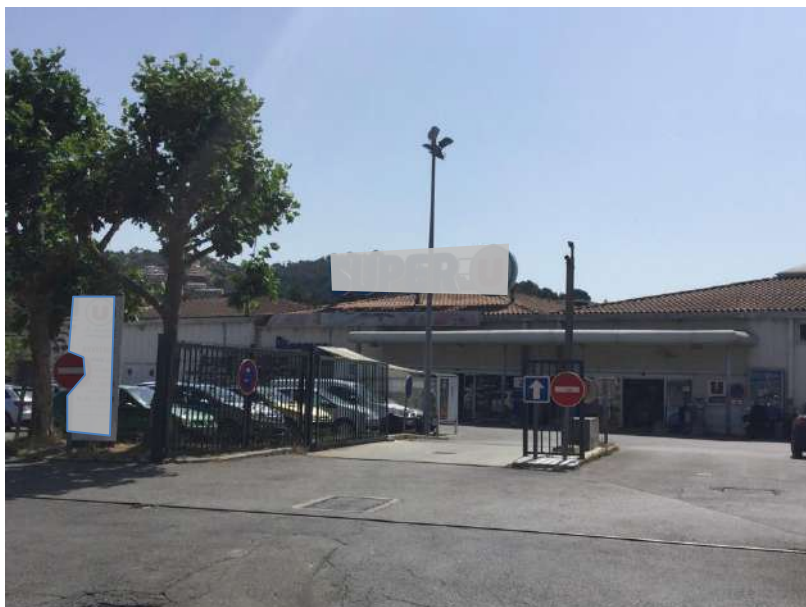
Enseigne sur toiture réalisée en lettres ou signes découpés, Pégomas.
